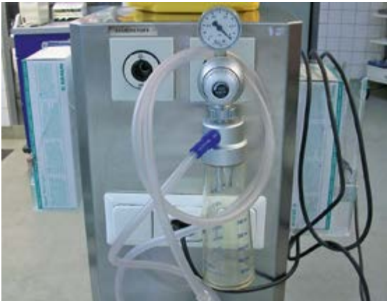
Abb. 2-9 Integrierte Vakuumsaugung mit zentraler Unterdruckversorgung. Diese zentrale Technik ist insbesondere für größere Kliniken geeignet.
